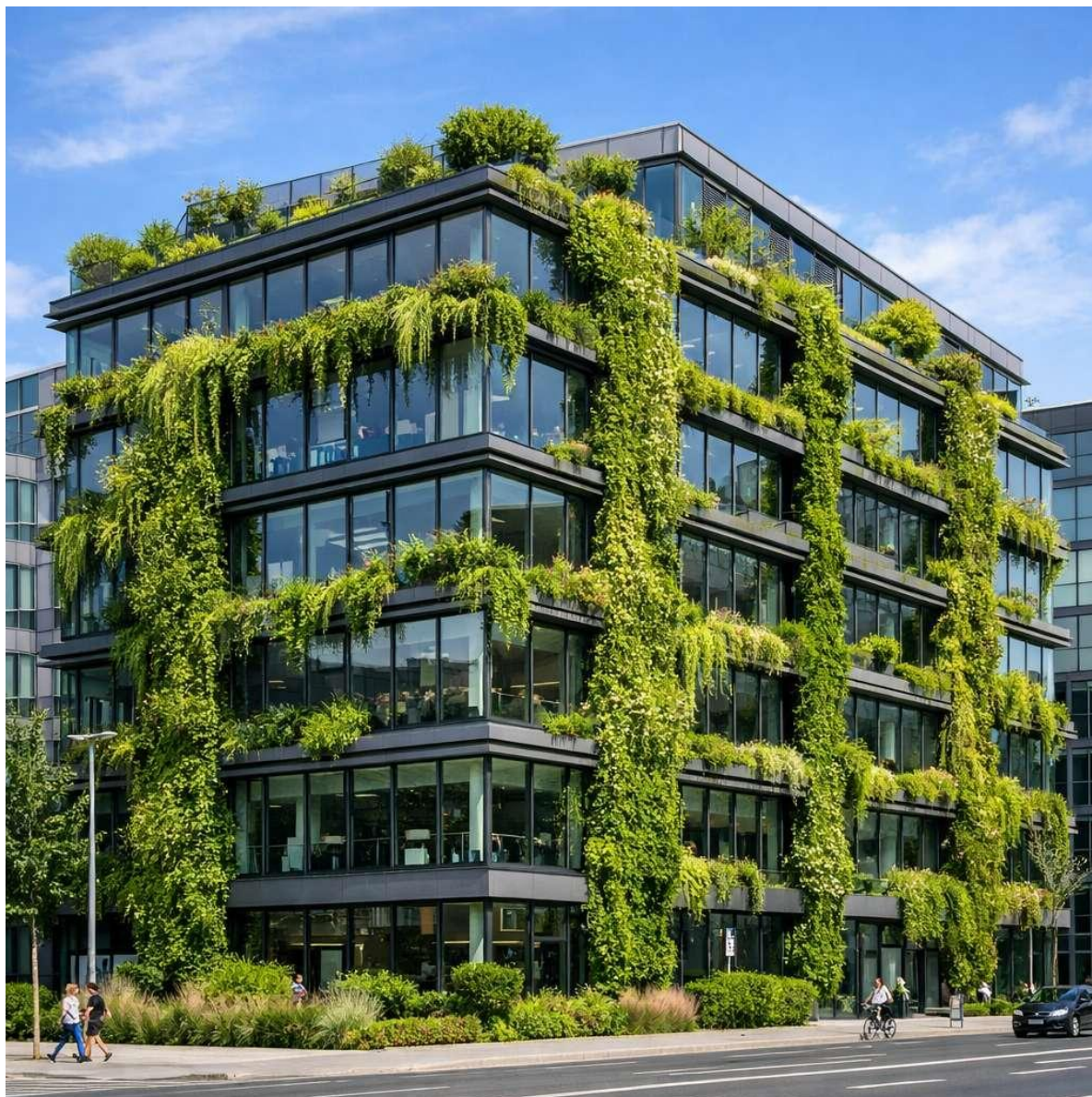
Figură 4. Exemplu de fațadă verde pe o clădire de birouri. Sursă: Proiectant
